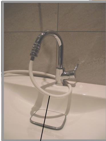
2.) Wechsel-Kupplungsstück anstelle des abgeschraubten Perlatoren anschrauben.
