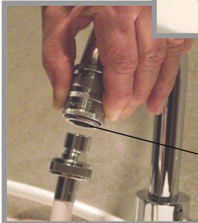
3.) Verriegelungsring an Kupplungsstück nach oben schieben, Adapter in Kupplung einstecken, Verriegelungsring wieder nach unten schieben, fertig.
